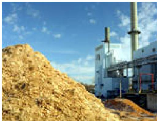
No caso de uma central de cogeração, o calor residual originado nos processos termodinâmicos de geração de energia eléctrica é também aproveitado.
