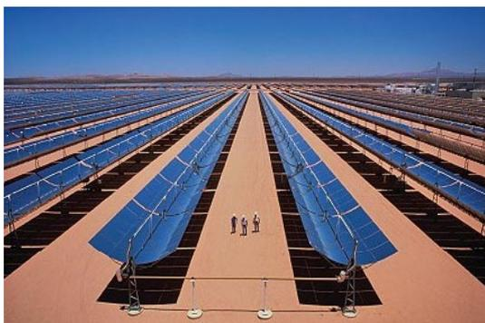
**Energia Termo-Solar:** A energia termo-solar permite o aproveitamento da energia do sol, sob a forma de calor, para a geração de energia eléctrica. Uma das tecnologias utilizadas é a Concentração de Radiação Solar, através de colectores cilindro-parabólicos, receptores de energia solar que se ligam em paralelo e reflectem calor para uma tubagem isolada termicamente.
